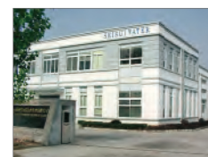
蘇州整水綜合水処理有限公司
