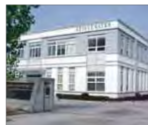
蘇州整水綜合水処理有限公司
